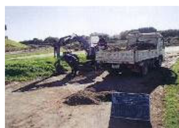
越流後の堆積土の除去作業
